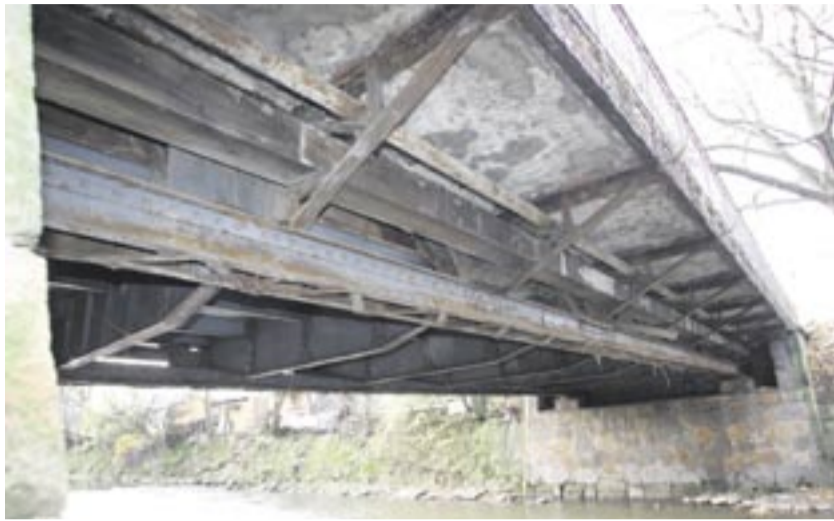
Fiel im ADAC-Test durch: eine Brücke in Chemnitz.
