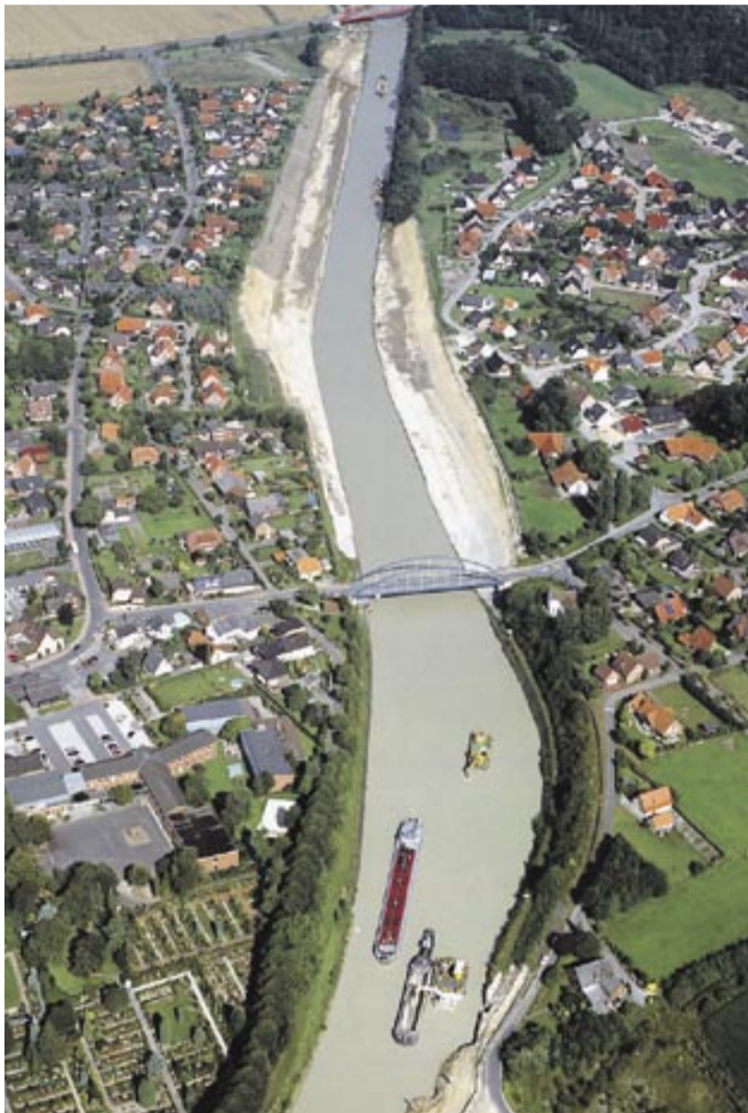
Der Dortmund-Ems-Kanal bei Riesenbeck während des Ausbaus. Foto: WSA Rheine
