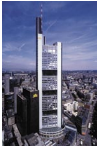
War der erste Öko-Wolkenkratzer in Deutschland: das Commerzbank-Hochhaus. Foto: Ralph Richter, Commerzbank AG
