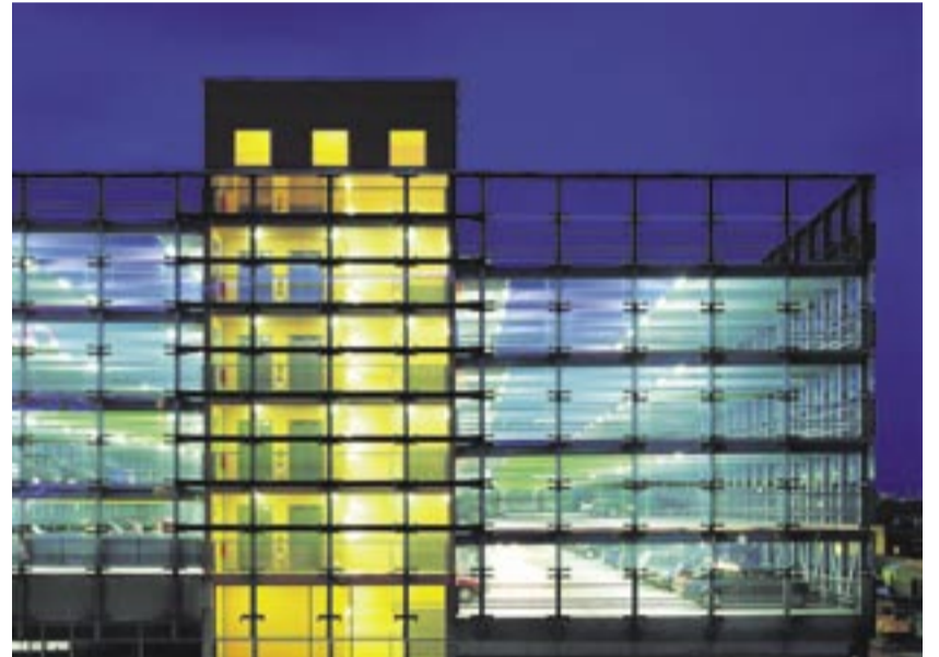
Die Software eignet sich für die rechnergestützte Kostenkalkulation bei der industriellen Systembauweise, wie sie beim Bau des Parkhauses am Hauptbahnhof in Bielefeld angewandt wurde.
