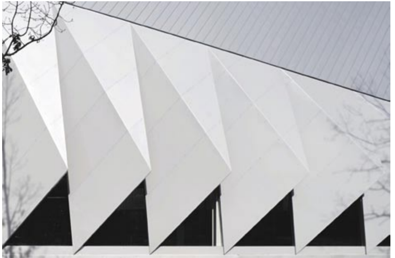
Die neue Versuchshalle der TU Darmstadt.
