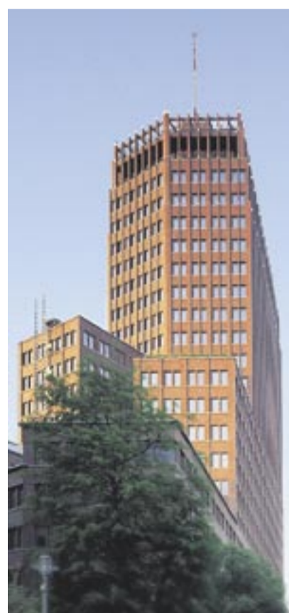
Statt Glas- oder Betonfassade bevorzugten die Bauherren eines fast hundert Meter in die Höhe ragenden Hochhauses am Potsdamer Platz in Berlin gebrannte Naturziegel. Für das Projekt nutzen die Erbauer das Know-how der in Ostriesland ansässigen Ziegelei Wittmunder Torfbrandklinker. Foto: CVS
