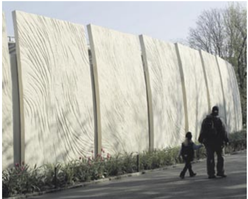
Optik ist alles: Der Betonfassade des neuen Elefantenhauses im Kölner Zoo verpasste man die Struktur einer Elefantenhaut.
