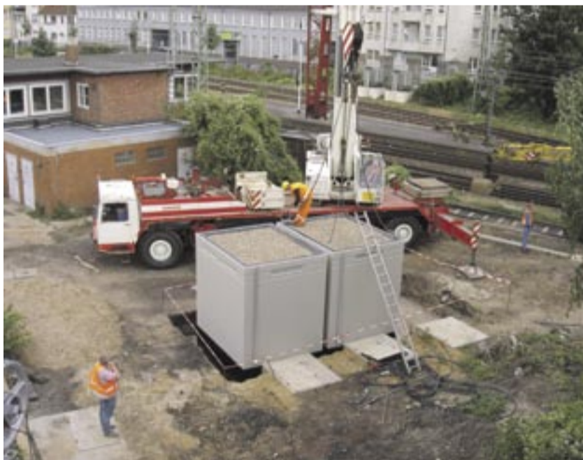
Am Hildesheimer Bahnhof wurde während des gesamten Projektverlaufs ein Baubüro installiert. Auf diese Weise konnten alle am Projekt beteiligten Bauleiter unmittelbar von der Baustelle aus auf die Arriba-Lösungen jederzeit zugreifen.
