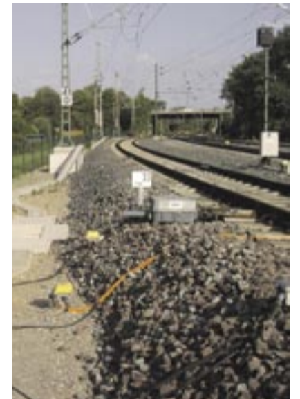
Die Projektmitarbeiter waren fast zwei Jahre lang auf der Großbaustelle Hildesheimer Bahnhof beschäftigt. Ein zuverlässiges Baumanagement und eine sichere kaufmännische Steuerung sind bei Projekten in diesem Umfang unabdingbar.
