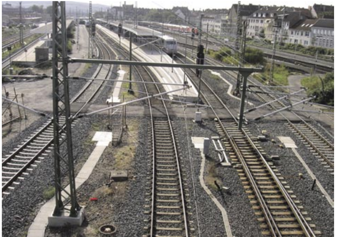
In diesem Jahr realisierte die Frenzel-Bau-Gruppe die komplette Umstellung des mechanischen Stellwerks am Hildesheimer Bahnhof auf ein elektronisches. Alle Weichen und Signale des niedersächsischen Bahnhofs mussten im Rahmen des Projekts neu verkabelt werden.
