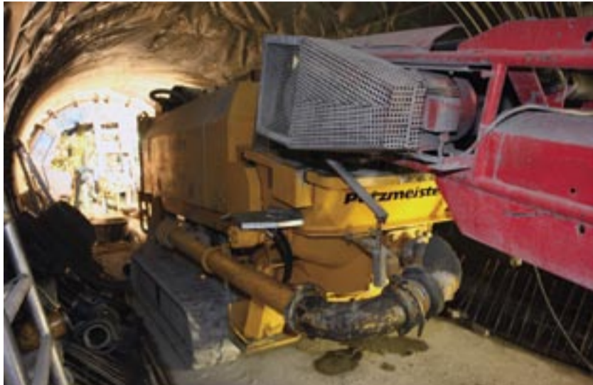
Nur 1,7 Meter in der Breite misst die Betonpumpe auf dem Raupenfahrwerk, die nach der Betonage mit eigenem Antrieb wieder aus dem Tunnel fährt. Fotos: Putzmeister
