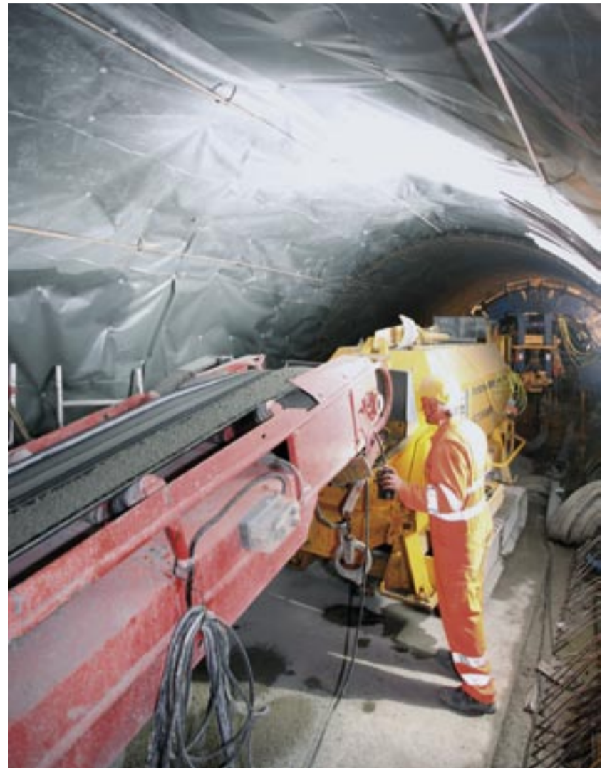
Ein Förderband übergibt den Beton in den Trichter.
