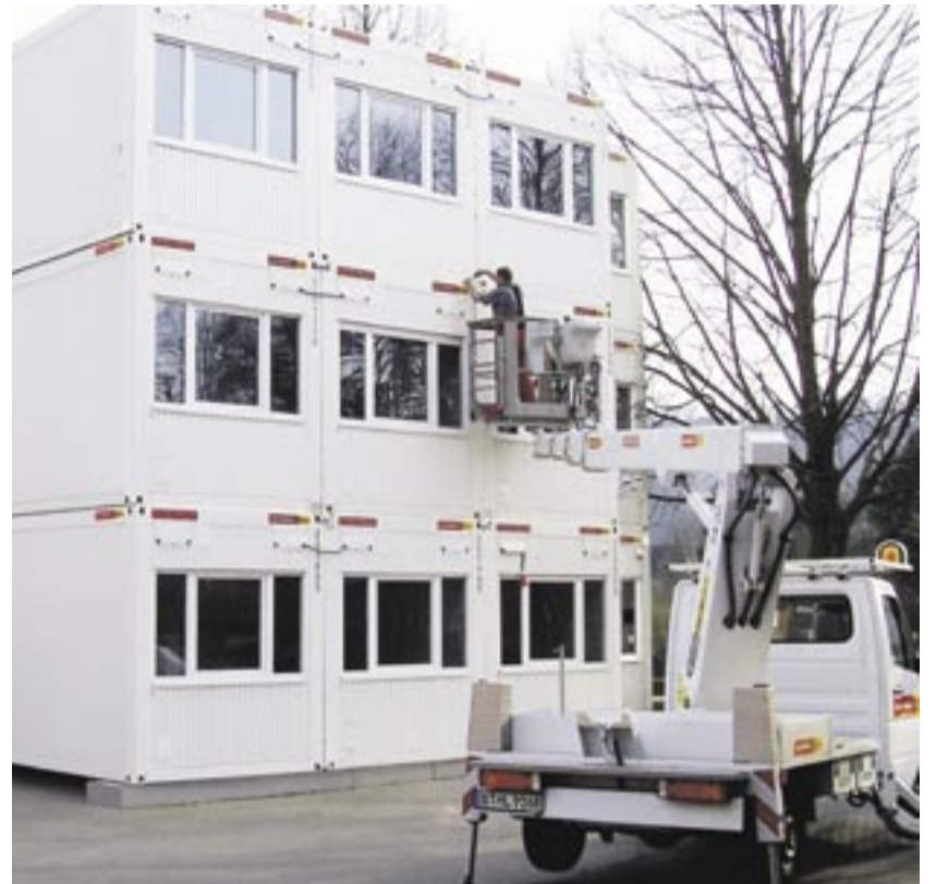
Container-Experte von MVS Zeppelin bei der Arbeit: Schnell und professionell werden die einzelnen Module montiert. Foto: MVS Zeppelin
