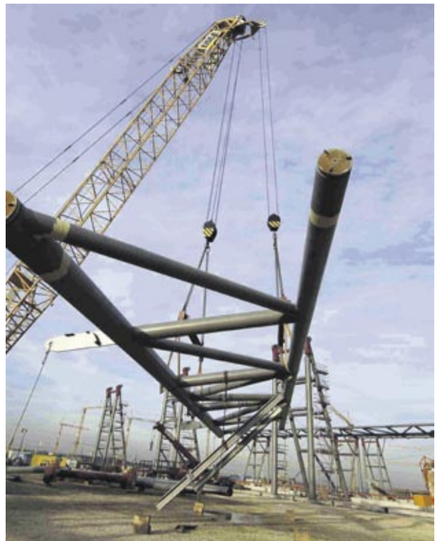
Auch Stuttgarts derzeit größte Baustelle steht auf dem Besichtigungsprogramm: die Neue Messe.
