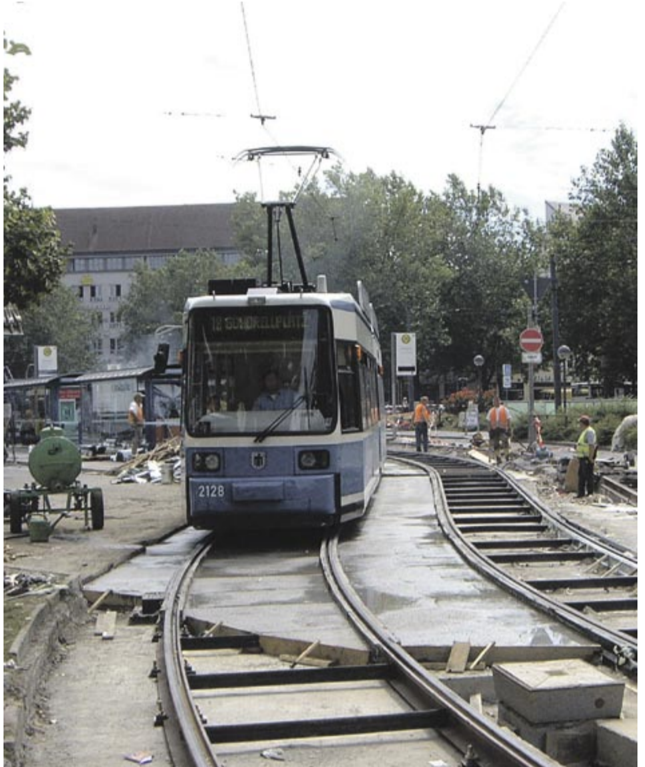
Gleisbauarbeiten für die Straßenbahn auf der Münchner Maximilianstraße verlangen besondere Sorgfalt.
