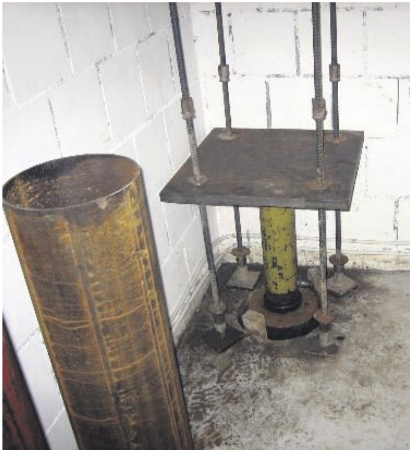
Über insgesamt zwölf computergesteuerte hydraulische Hubeinheiten wurde die gesamte Bodenplatte samt Haus innerhalb von drei Wochen Schritt für Schritt um insgesamt 1,15 Meter nach oben gehoben. Foto: HeidelbergCement
