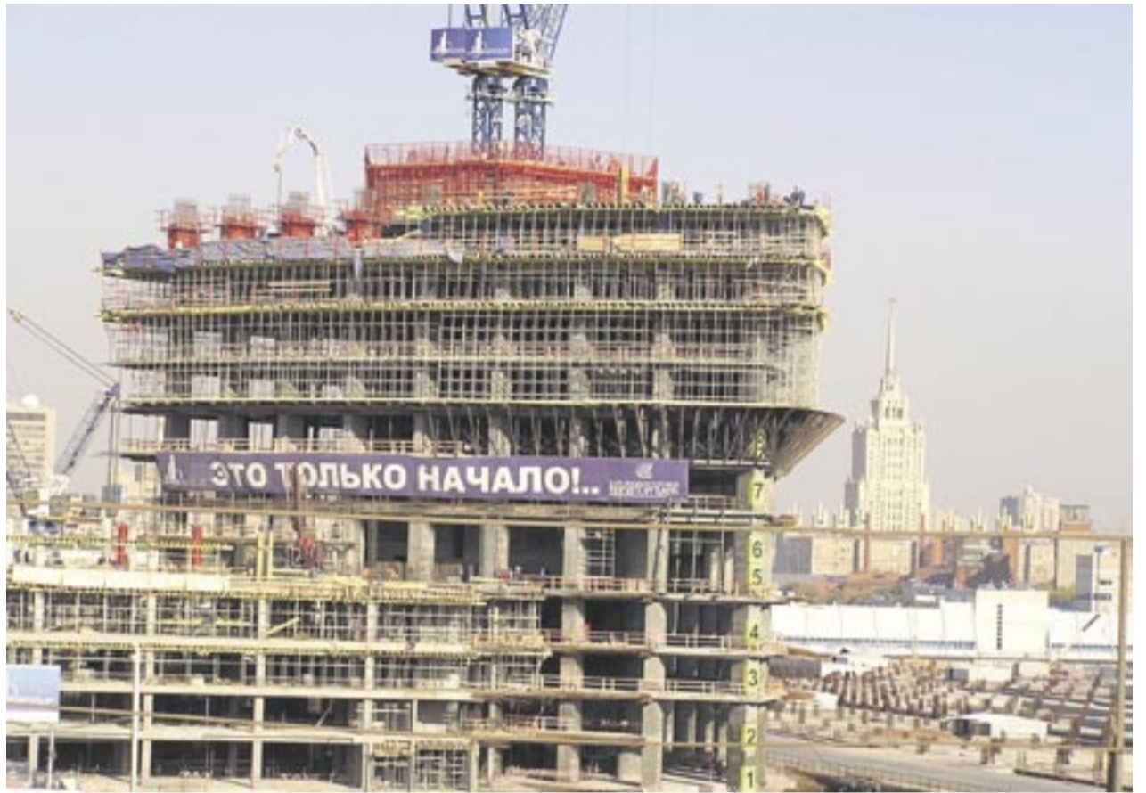
Beim Klettern der Kerne wird eine Mammut-Rahmenschalung eingesetzt.
