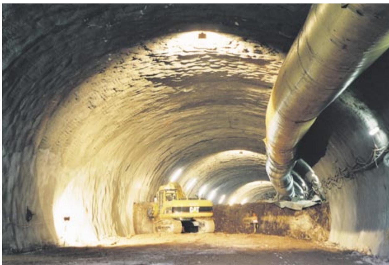
Arbeiten an der Hauptröhre des Schottenbergtunnels bei Meißen.
