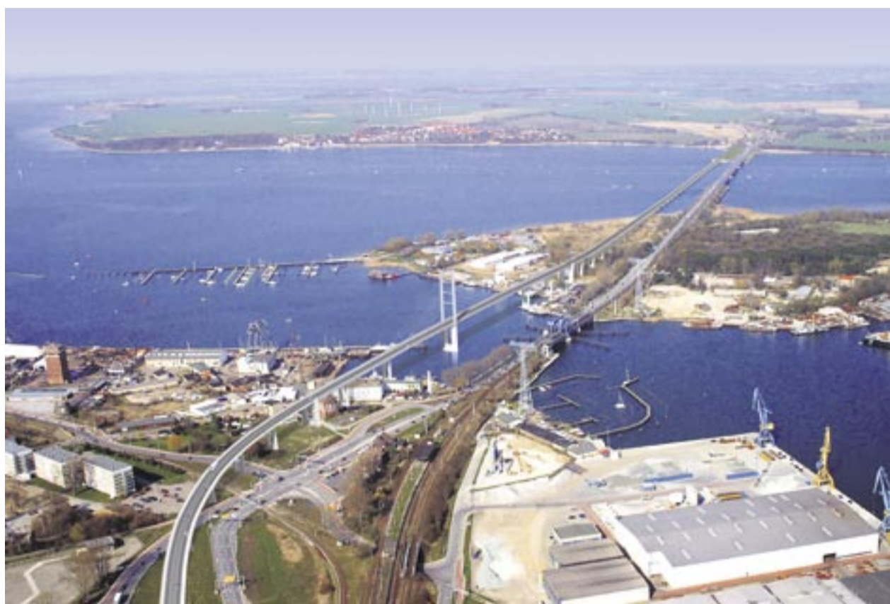
Neue Strelasundquerung und alter Rügendamm.
