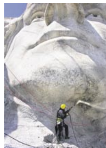
Präsidentenköpfe am Mount Rushmore werden mit Kärcher-Hochdruckreinigern von Flechten, Moosen und anderen Verunreinigungen befreit. Hier reinigt Thorsten Möwes, Anwendungstechniker beim deutschen Reinigungsgerätehersteller, testweise das Kinn von Thomas Jefferson. Foto: Kärcher
