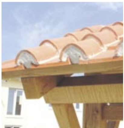
Schneesicher: Die Deckziegel auf der Fläche sowie im First wurden vermörtelt. Fotos: Meindl
