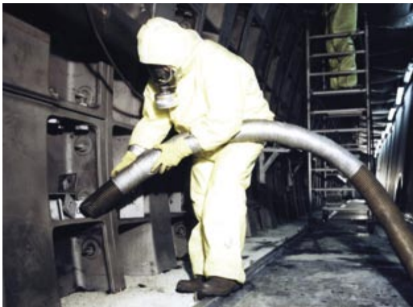
Sanierung der ältesten Elbtunnelröhre: Der alte, asbesthaltige Brandschutz und der darunter liegende, ebenfalls mit Gefahrstoffen kontaminierte Korrosionsschutz wurden unter strikten Sicherheitsvorkehrungen entfernt. Fotos: PeinigerRöRo
