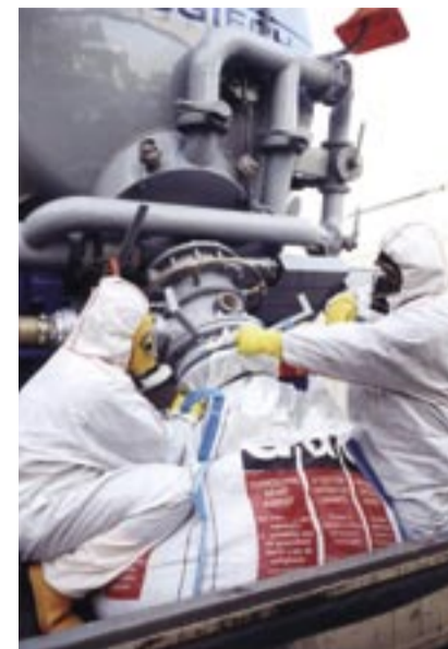
Strenge Sicherheitsanforderungen galten auch beim Entsorgen des asbesthaltigen Strahlguts.
