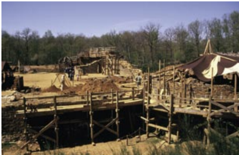
Eine der spektakulärsten Baustellen in Europa: Guédelon! Hier entsteht eine Burg, doch erst auf dem zweiten Blick ist erkennbar: Die Zeitreise in das Jahr 1235 bedeutet auch, dass keinerlei moderne Materialien oder Werkzeuge verwendet werden. Rechts der Bergfried, im Hintergrund Wohnhaus und Eckturm. Foto: Frank G. Gerigk
