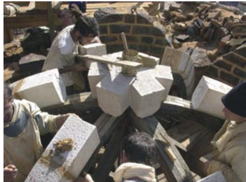
Kurz vor der Vollendung des Gewölbes des Kellers im Bergfried wird der sechsstrahlige Abschlussstein für das Kreuzrippengewölbe gesetzt. Auf den Innenseiten der sehr fein gehauenen Bogensteine sind Sickerschlitz für den Mörtel zu erkennen. Beim gotischen Kirchenbau, wo größere Drucklasten abzutragen sind, wird man überlegen, die Steine stattdessen mit flüssigem Blei unverrückbar miteinander zu verbinden. Foto: © Guédelon
