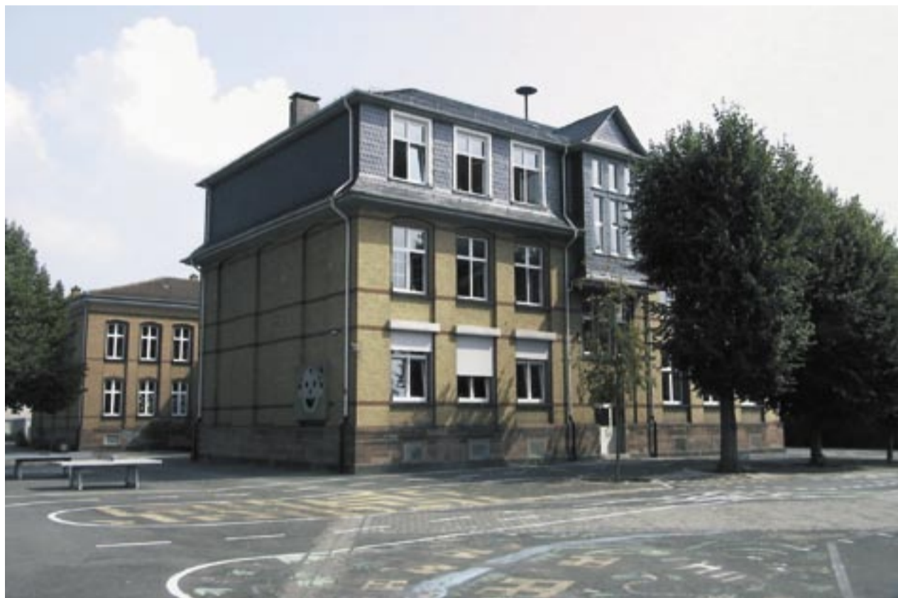
Die Goetheschule in Mühlheim ist eine von insgesamt 49 Schulen im Kreis Offenbach, die HOCHTIEF ab dem 1. Januar 2005 auf Basis eines Public-Private-Partnership-Vertrages finanzieren, sanieren und betreiben wird. Die insgesamt fünf Gebäude umfassende Schule wird von HOCHTIEF innerhalb der ersten fünf Jahre saniert und über einen Zeitraum von 15 Jahren bewirtschaftet.
