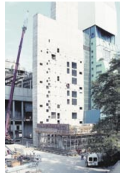
Kapazitätsausbau im EnBW-Restmüll-Heizkraftwerk Stuttgart-Münster: Mit zwei horizontalen und zwei vertikalen Betonierakten wurde die Bunkerwand auf 22 Meter erhöht. Fotos: Meva
