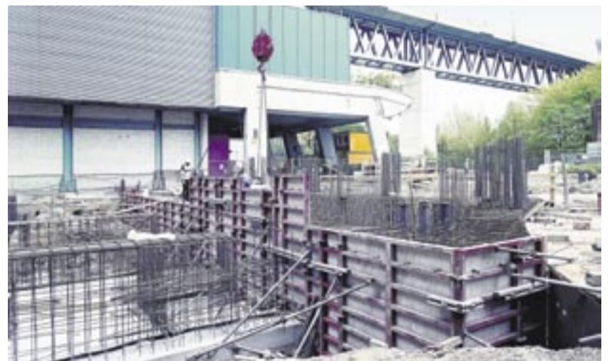
Auch bei den Fundamenten kam die „Mammut“-Schalung von Meva zum Einsatz.
