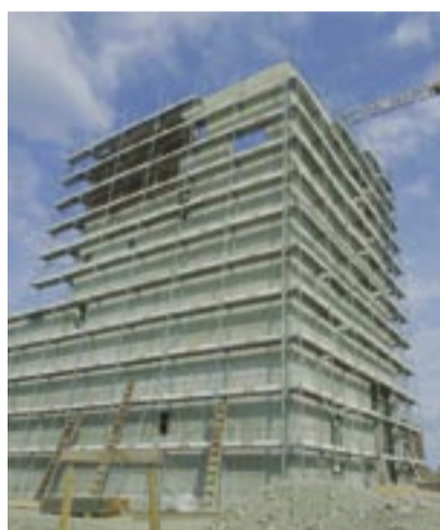
Noch im Bau ist das moderne Biomasse-Heizkraftwerk in Hengersberg (Bayern). Der über 24 Meter hohe Turm wird den aufrecht stehenden Heizkessel aufnehmen. Foto: PASCHAL
