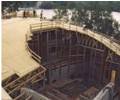
Das neue „Hans Otto Theater“ in Potsdam: 1 000 Kubikmeter Beton - eingebaut in drei Arbeitsschritten auf den bis zu 55 Prozent geneigten, wellenförmigen Muscheldächern. Umfangreiche Tests an Modellflächen mit entsprechender Neigung und Schalhaut gingen diesem Theaterprojekt voran. Foto: Nemetschek
