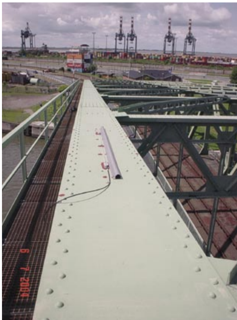
Die große Drehbrücke in Bremerhaven unter Hightech-Aufsicht. Foto: TÜV Rheinland
