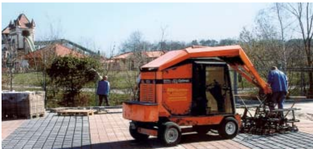
Ob Parkplatztaschen für Busse oder für Pkw: Überall sorgt das Pflastersystem UNI-Priora Öko für einen ökologischen Ausgleich. Foto: Sepp Rixner kommunikation-bau
