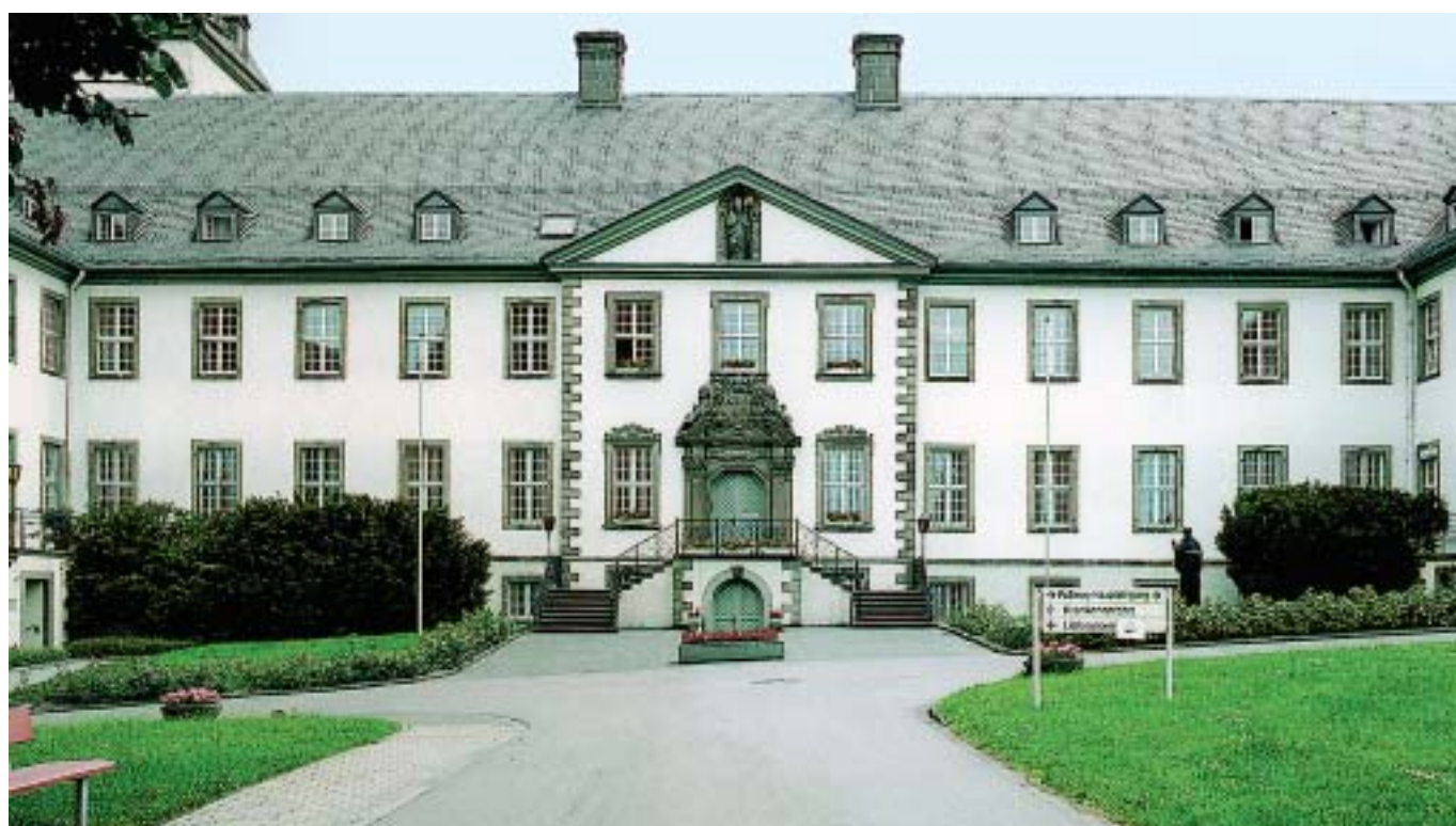
Wurde zu einer altersgerechten Wohnanlage umgebaut: ehemalige Krankenpflegeschule im sauerländischen Schmalleberg.
