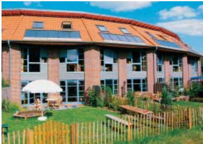
Liefern kostenlose Wärme für Wohnräume und Wasser: Solarheizsysteme (z.B. „SolvisMax“). Zudem setzen Kollektoren auf dem Dach architektonische Akzente (wie hier in Geesthacht).
