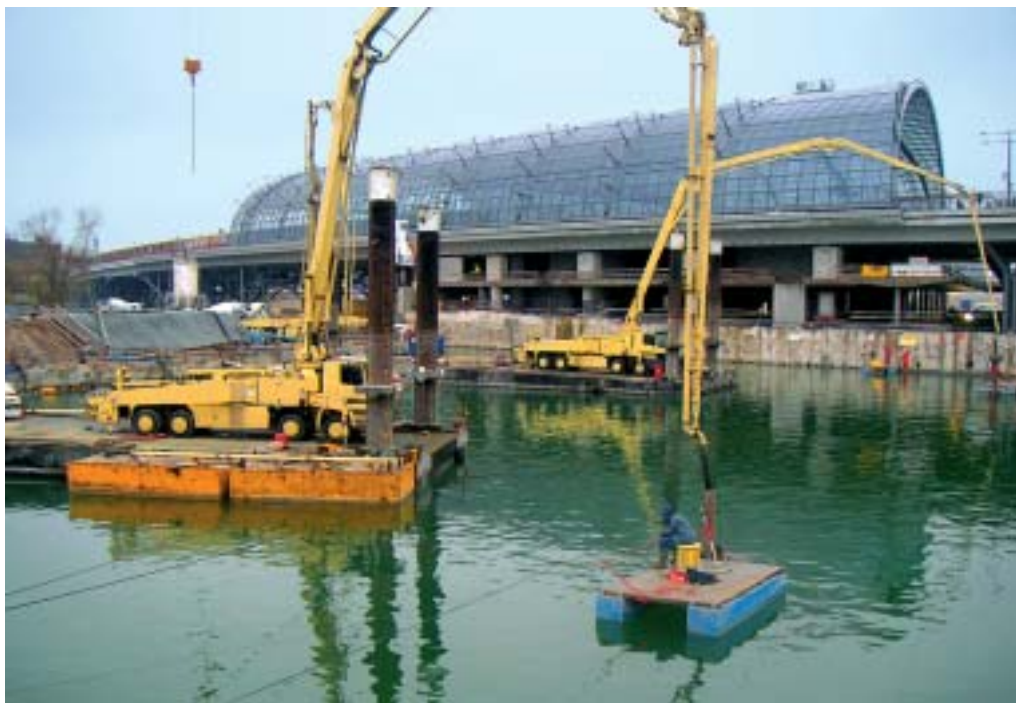
Zwei der sechs Betonpumpen befanden sich während der Betonage auf Pontons im Wasser, um jeden Punkt der großflächigen Baugrube zu erreichen.
