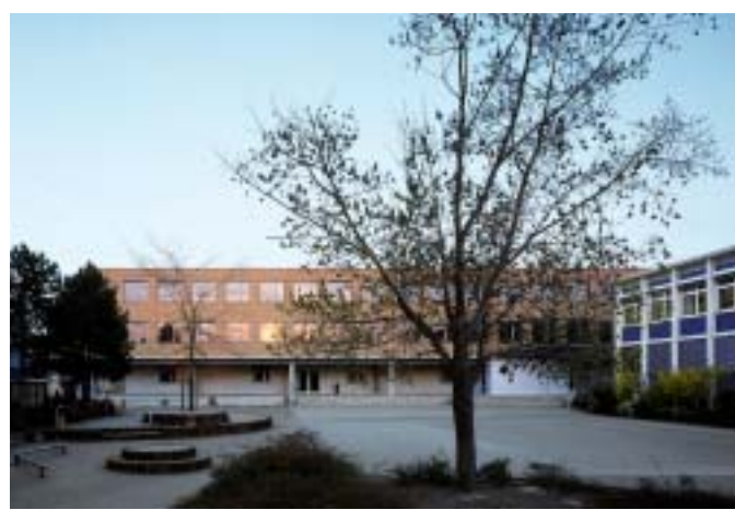
Die Dreieichschule in Langen. Eine von 41 Schulen, die künftig von einem privaten Träger saniert und betrieben werden wird.
