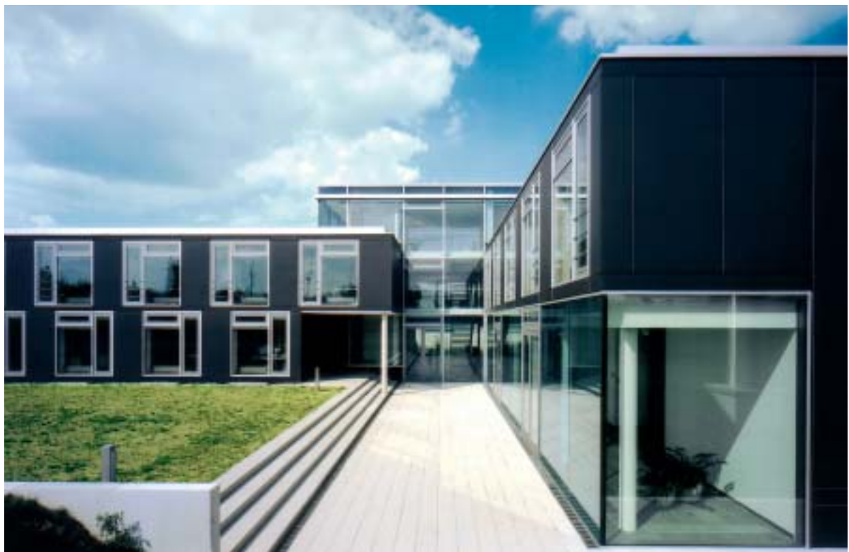
Preisträger Deutscher Fassadenpreis 2004: Heinle, Wischer und Partner, Freie Architekten, Dresden – Neubau Büro- und Servicezentrum des Bildungswerkes der Sächsischen Wirtschaft, Dresden. Foto: Grimmstein
