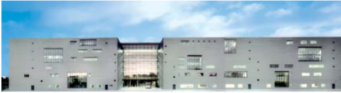
Preisträger Deutscher Fassadenpreis 2004: Schuster Architekten, Düsseldorf – Neubau Zentrale Polizeitechnische Dienste, Duisburg. Foto: Springer
