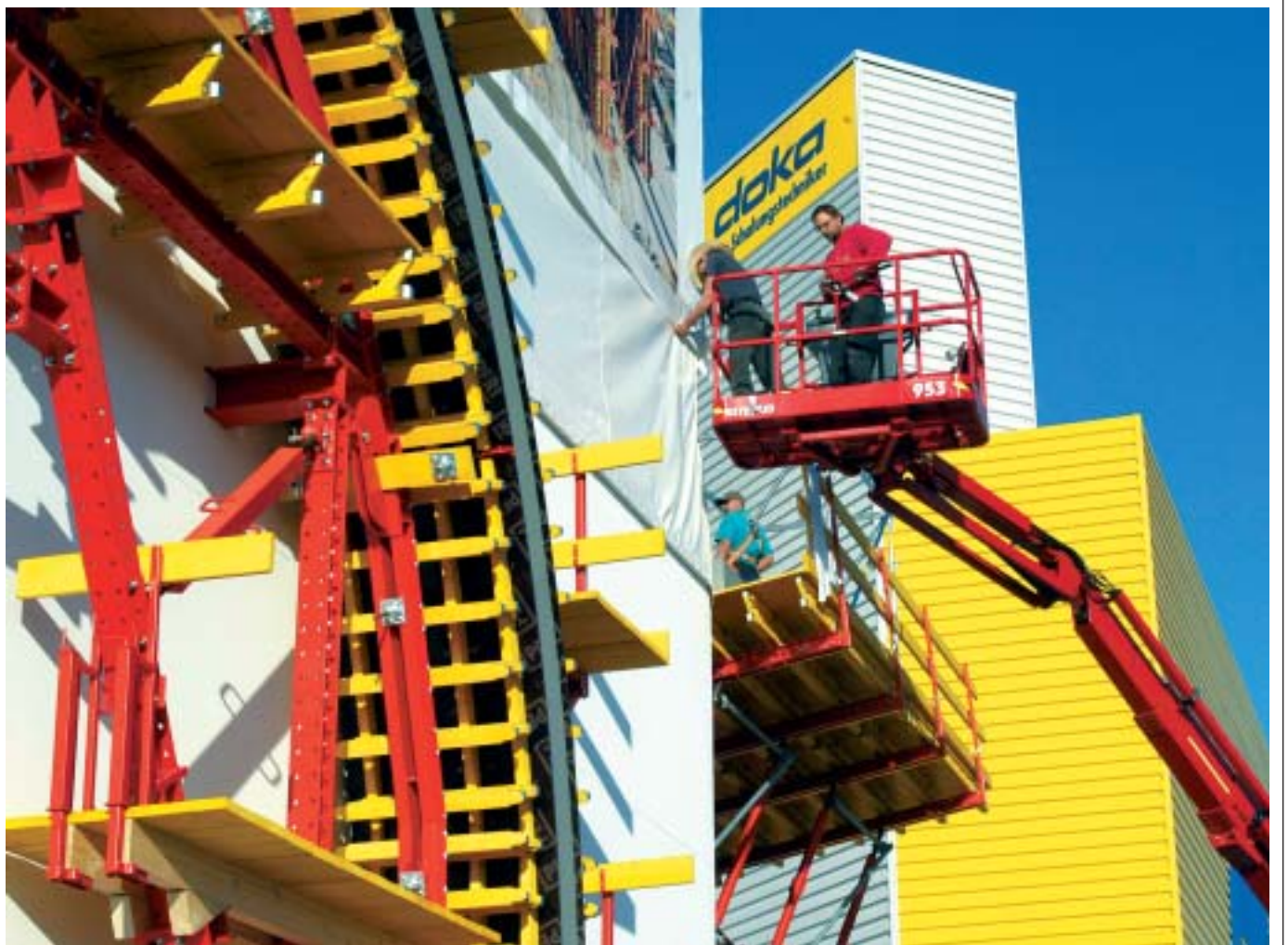
Vorbereitungsarbeiten bei den Schalungstechnikern für den Messeauftritt auf der „bauma 2004“.
