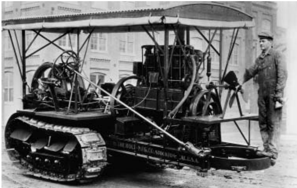
Nanu? Hatte dieser Holt-Raupenschlepper das Vorderrad verloren? Nein, ein Photograph war pünktlich bei einem historischen Moment in der Evolution der Raupenfahrzeuge anwesend: Mit dem fehlenden Lenk-Vorderrad wurde 1915 demonstriert, dass ein „Caterpillar“-Raupenschlepper nur mit seinen Raupenfahrwerken lenken konnte – das Vorderrad wurde nicht mehr benötigt.
