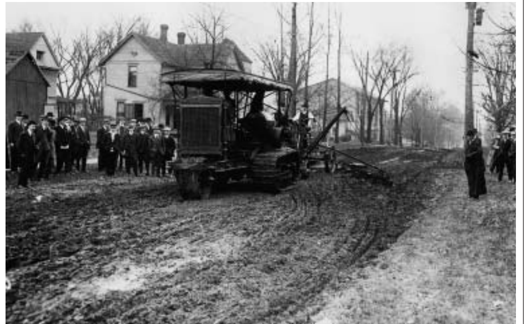
Bald schon zeigten sich die vielen Vorteile der Raupentraktoren von Holt nicht nur in der Landwirtschaft, sondern auch bei Bauarbeiten: Ein Holt „75“ (was auf 75 PS Motorleistung hinwies) zog vor der „Good Roads School“ der Universität von Illinois einen Anhängegrader mit seitlicher Profilliereinrichtung, der zerwühlte Straßen ebenen konnte.
