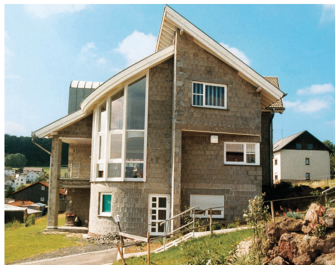
Dämpft ohne zusätzliche Maßnahmen bis zu 99 % der hochfrequenten Strahlung: der Wandbaustoff Leichtbeton.
