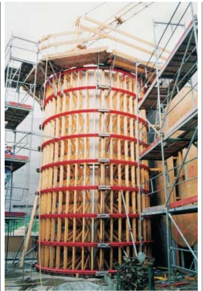
Bau des Medienturms am neuen Firmensitz des Krick-Verlags. Die Ringgurtung der Außenschalung wird vom Gerüst aus geschlossen.
