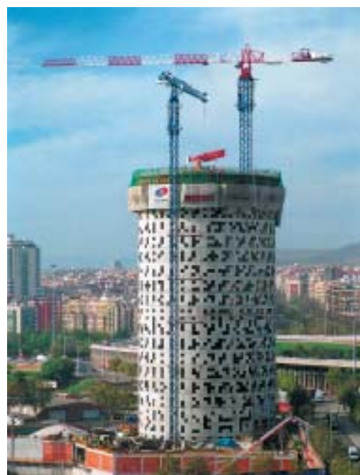
Mithilfe von Peri-Schalungstechnik und -Know-how wird alle fünf Tage eine komplette Stockwerkshöhe fertig: der Agbar Torre in Barcelona.
