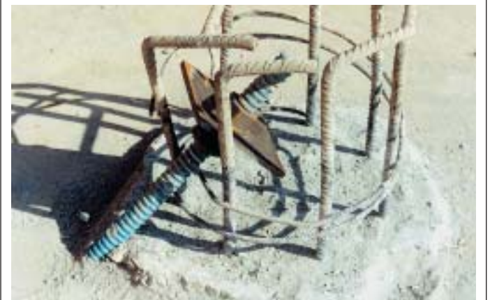
Alle Enden der Bohrpfähle „Titan 40/16“ sind mit einer ihnen aufgeschraubten Kalottenplatte in die Fundamentbewehrung eingebunden worden, so dass bereits alle auftretenden Horizontalkräfte an der Stützmauerwurzel abgetragen werden können.
