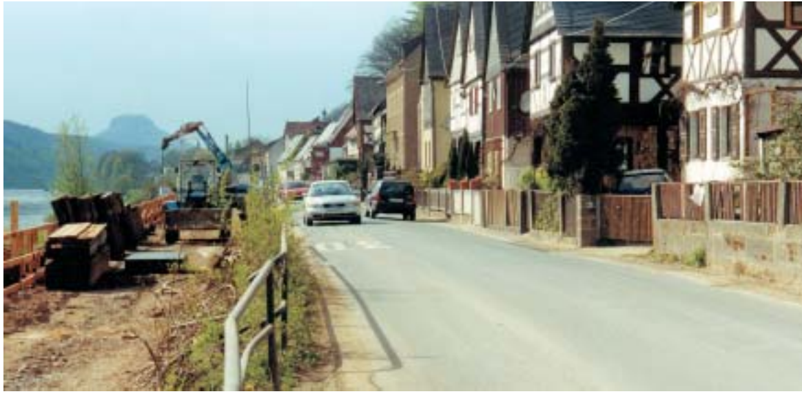
Als kürzlich hinter Bad Schandau bei Postelwitz der bislang äußerst schmale Abschnitt der B 172 auf Normmaß verbreitert worden ist, galt es, die Trasse zur Elbe hin mit einer Stützmauer abzufangen. Deren Fundament sicherten die Arbeiter mit jeweils 12 000 mm langen selbstbohrenden Verpressgliedern „Titan 40/16“ von Ischebeck gegen horizontale Abtrift.
