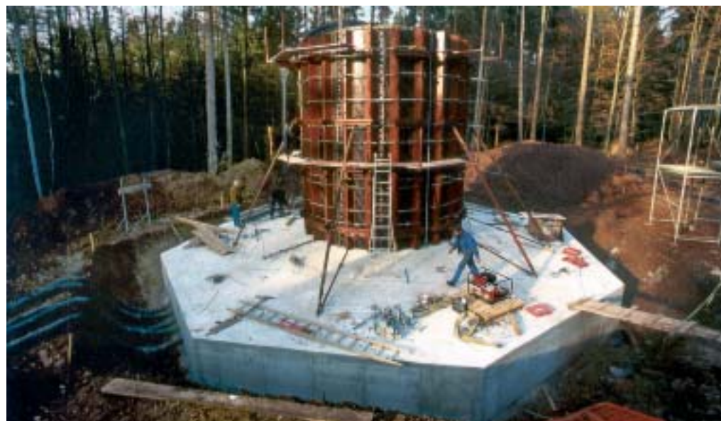
Bau einer Windkraftanlage oberhalb der Schwarzwaldgemeinde Mahlberg: Erst nach 40 Tagen war das Fundament voll belastbar. Die radienverstellbare „Trapezträger“-Rundschalung von Paschal umschließt spannstellenlos den Rundsockel.
