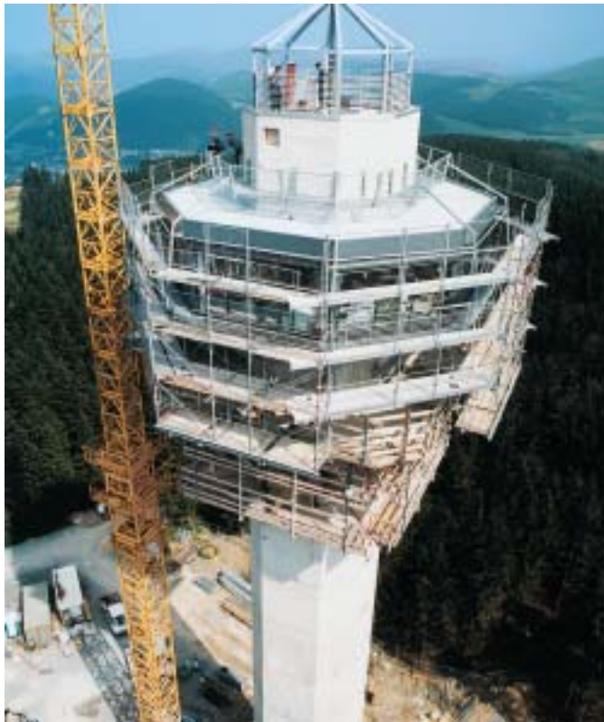
Dank „SCF“-Selbstkletterschalung wuchs der achteckige Willinger Hochheideturm auf nur 8 Kletterkonsolen um 7,34 m pro Woche. Zum Herstellen der Aussichtskanzel wurde das „SCF“-System zwei Takte nach unten geklettert und zu einer 5 m tiefen Arbeitsplattform verbreitert.
