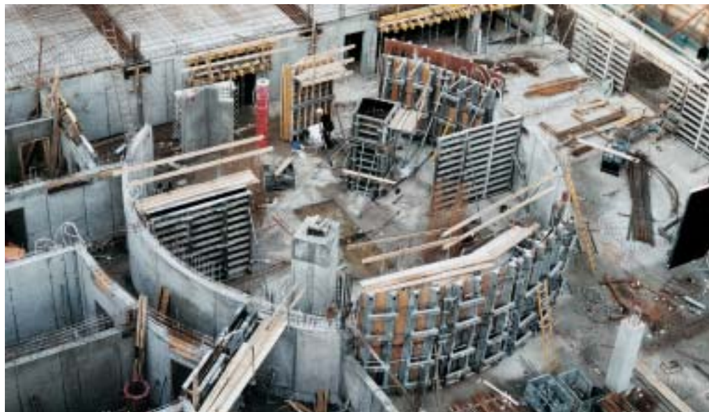
Zum Bau der so genannten Oase – einem bis zu 11 m hohen, runden Raum innerhalb des Botschaftsgebäudes – setzen die Schalungsbauer die „Ronda“-Rundschalung ein. Sie lässt sich millimetergenau auf Radien ab 2,75 m einstellen und ist einfach aufstockbar.
