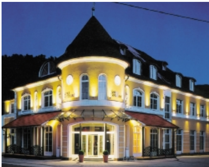
Außenwände aus Poroton-Ziegeln: Kräuterhaus Sanct Bernhard.
