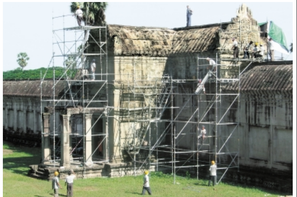
Rund 500 m 3 Gerüstmaterial stellte Hünnebeck für die Erhaltung der Reliefs und Skulpturen am Angkor-Wat-Tempel in Kambodscha zur Verfügung. Angkor ist eine der weltgrößten Tempelstädte.
