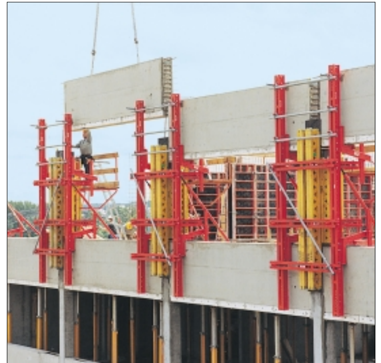
Fertigteil-Fassadenschalung PERI FTF zur effizienten Erstellung von Fassaden in Mischbauweise.
