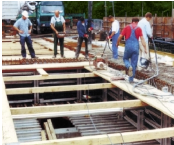
In zwei Arbeitstakten betonierten die Bauleute die neue Fahrbahnplatte. Zunächst stellten sie die beiden mit der leichten „Titan“-Deckenschalung geschalteten Längsunterzüge her.
