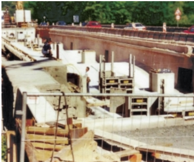
Sanierung der Dresdner Prießnitzbrücke: Bevor mit dem Neubau der Fahrbahnplatte begonnen werden konnte, galt es, zunächst den gesamten „Altbau“ bis auf die Gewölbeipfel des Brückentragwerks abzuräumen.
