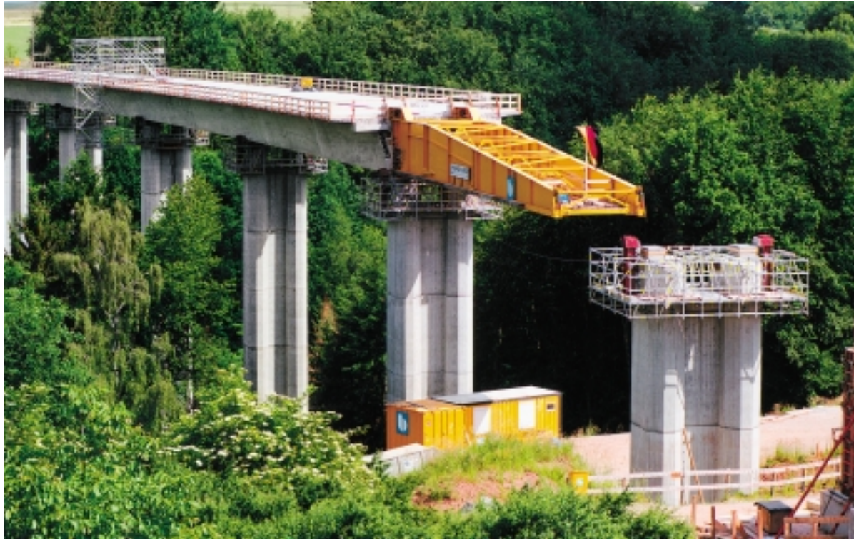
Großheimertalbrücke bei Pirmasens: Während des Verschiebevorgangs können die Monteure auf den „Peri Up“-Pfeilerkopf-Gerüsten die Bewegung der Brücke kontrollieren und die Überbau-Auflager (Teflonkissen) bei Bedarf nachlegen.
