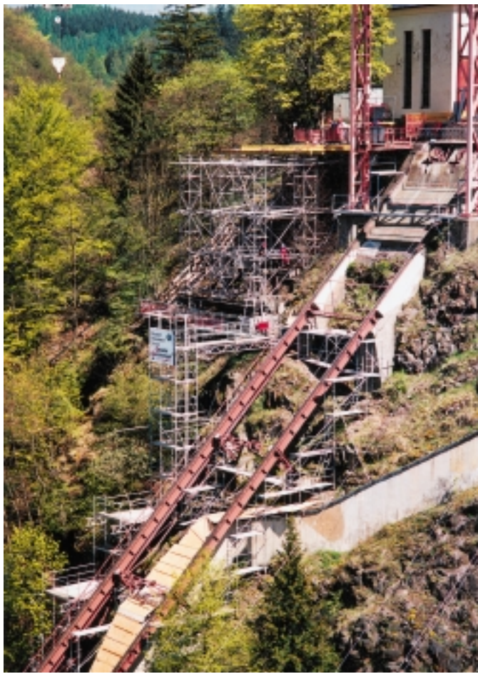
70 Jahre lang hat die alte Standseilbahn reparaturbedürftige Ausrüstungen aus dem Maschinenhaus des Wasserkraftwerks Bleilochtalsperre nach oben befördert – jetzt musste sie einem detailgetreuen Nachbau neuester Technik weichen.
