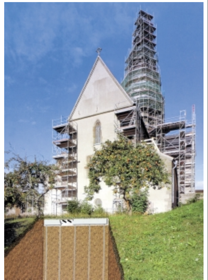
Die im Innern barock gestaltete Rasdorfer Stiftskirche aus dem 13. Jahrhundert gehört mit ihrem zum Teil noch aus dem 9. und 10. Jahrhundert stammenden figürlichen Säulenschmuck zu den nicht nur in Deutschland bedeutendsten Beispielen steinerer Bauplastik aus der Zeit vor 1200. Durch partielle Setzungen war der Bestand des Gotteshauses gefährdet.
