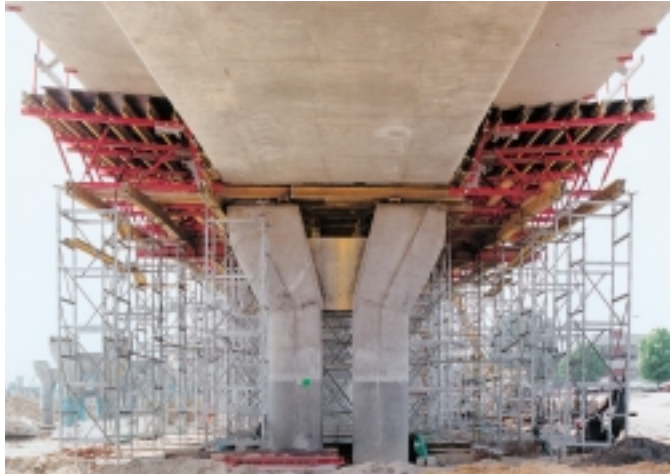
Trogaußen- und Kragarm-Schalung für den Überbau: mit „Vario GT 24“ und „Multiflex“.
