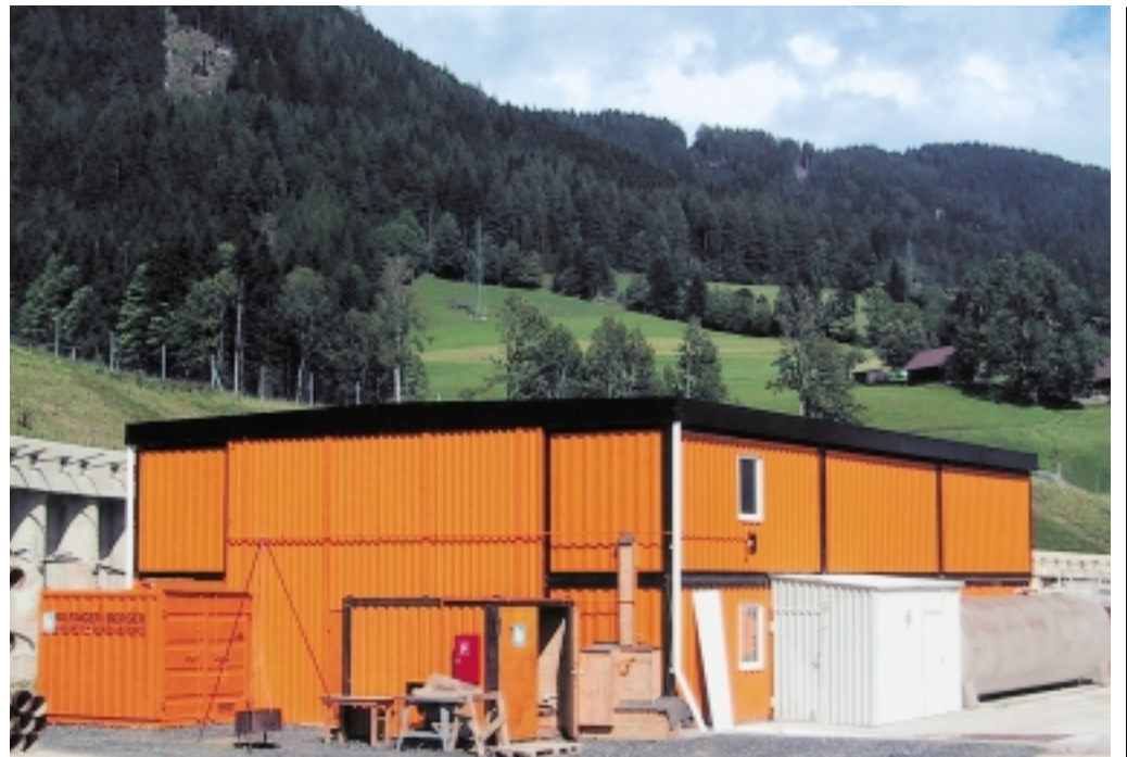
An der Tunnelbaustelle am Semmering bei Wien hatte die Raumlösung des Mannheimer Fertigbauspezialisten Premiere.
