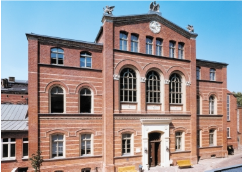
Universität Greifswald: Bei der Sanierung des Gebäudes aus preußischer Zeit sollte die historische Ausprägung so weit wie möglich erhalten bleiben – so auch die Holzbalkendecken.
