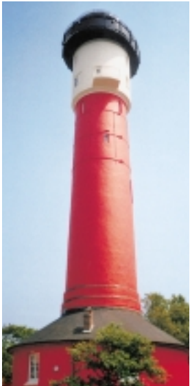
Keine Putzrisse mehr: Alter Leuchtturm in Wangerooze.
