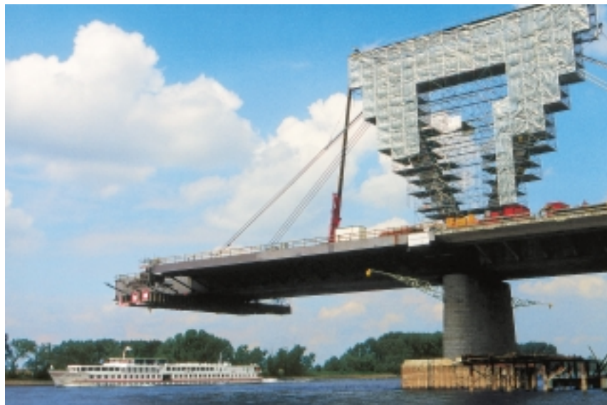
Autobahnbrücken-Neubau der A 44 über den Rhein bei Düsseldorf: Die Pylone wurden mit Layher-Allround-Hängegerüst eingerüstet. Grund waren Korrosionsschutz-Arbeiten an der Oberfläche.
