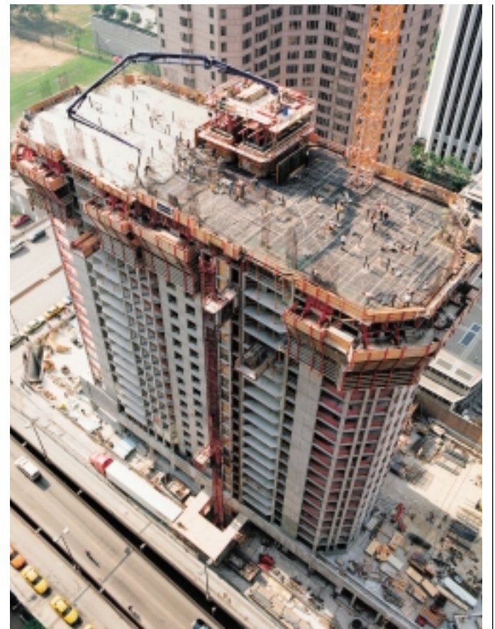
„Park Millennium Tower“ in Chicago: Am Gebäudekern klettert die „Vario“-Wandschalung von Peri auf „ACS-G“-Konsolen kranunabhängig von Etage zu Etage. Auch der 18 t schwere Putzmeister-Betonverteilermast wird vom „ACS“-System mit nach oben genommen.
