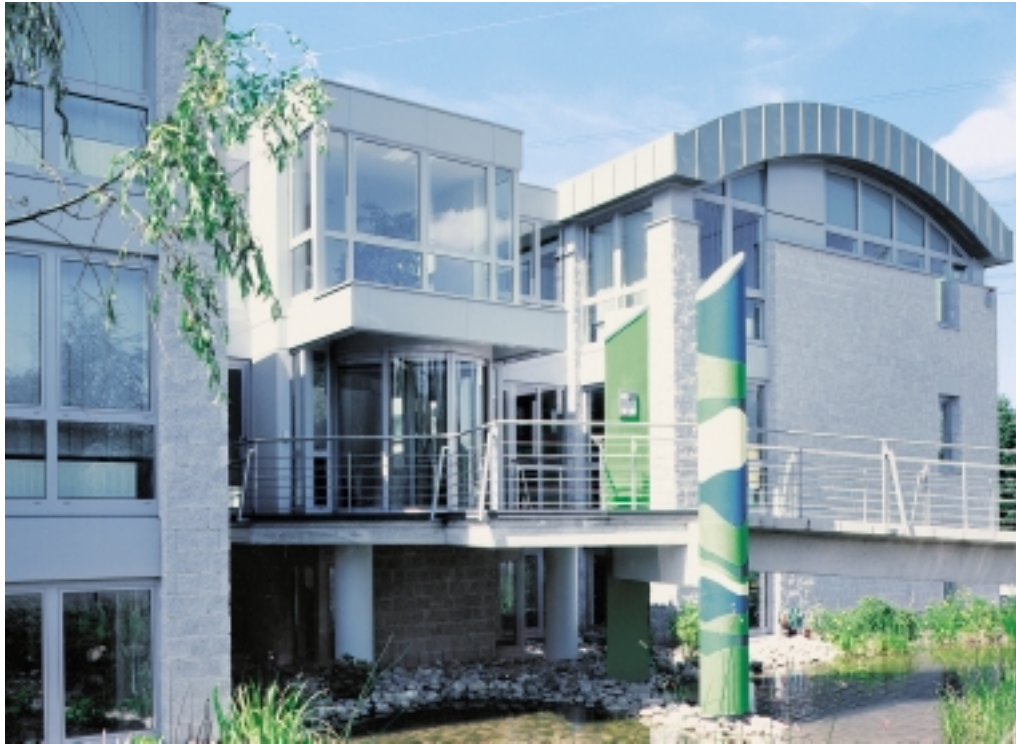
Bürokomplex in Bad Salzuflen: Ein gläsernes Forum verbindet die beiden Massivbauten. MBI-Splittsteine unterstreichen das Zusammenspiel unterschiedlicher Materialien und Formen.
