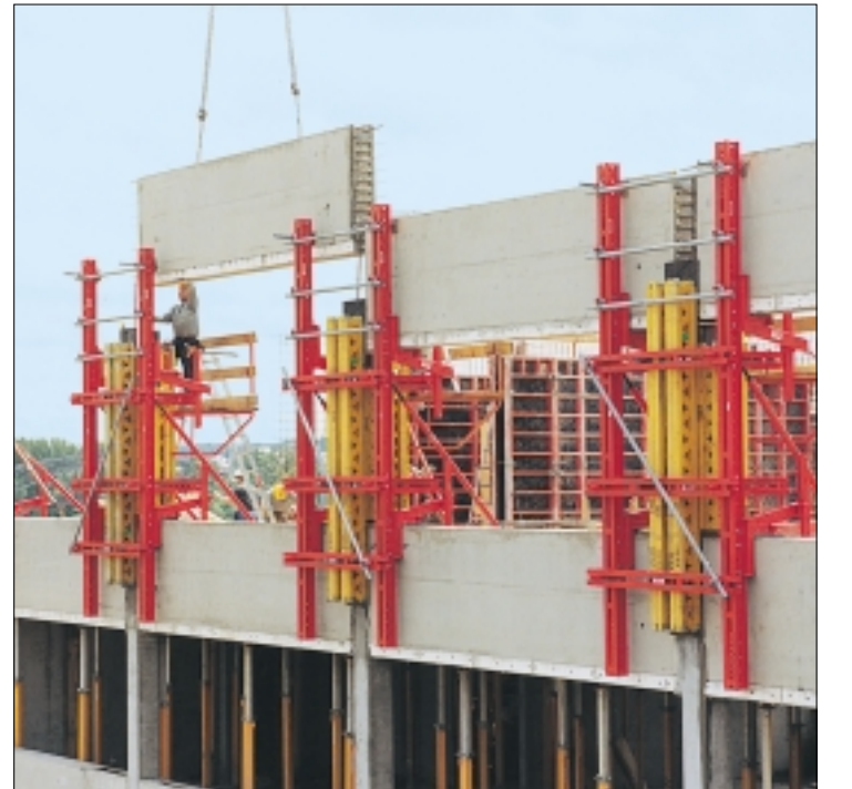
Fertigteil-Fassadenschalung PERI FTB zur effizienten Erstellung von Fassaden in Mischbauweise.
