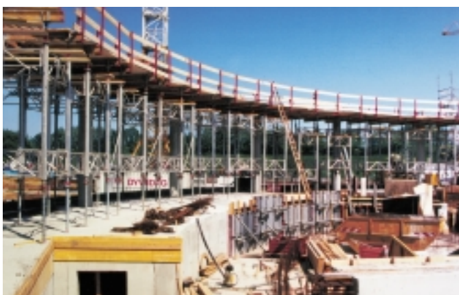
Auch bei der Rundschalung „Arcus“ erfolgt die Elementverbindung mit dem serienmäßigen Schalschloss. So ist sie mit allen Meva-Wandschalungen kompatibel.
