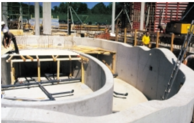
Freizeitbad Atlantis in Dorsten: Die Becken mit ihren verschiedenen, oft gegenläufigen Radien verlangten nach einer variablen Rundschalung. Die „Arcus“ erfüllte diese Forderung.
