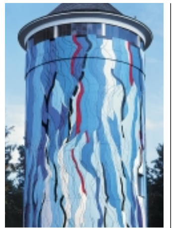
Ein Kunstwerk in brillanten Farben: der neu gestaltete Wasserturm von Eriskirch.
