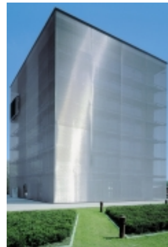
Für jede Gebäudeseite fertigte GKD je 4 Gewebepanellen (Maße: 22,80 x 5,20 m) vom Typ „Omega 1520“.
